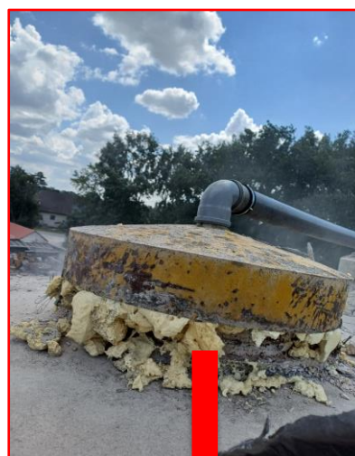
Incident 3 : Partie supérieure du silo à ciment tombée sur le camion-citerne puis sur le sol - Heureusement, personne n'a été blessé.
