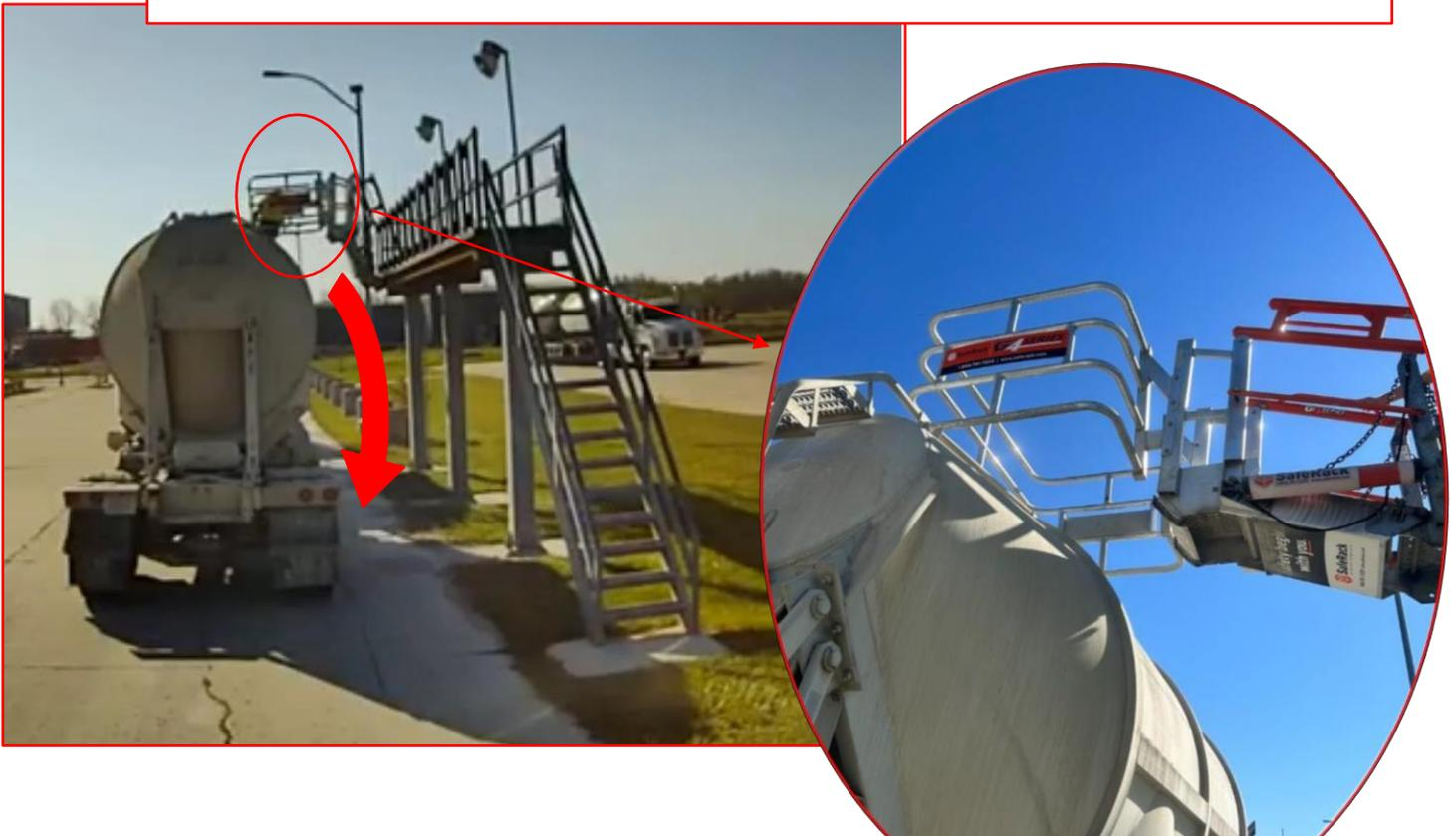
La position réelle du SafeRack abaissé démontre que la remorque est trop éloignée de la plate-forme, ce qui laisse un espace d'environ 75 cm.
