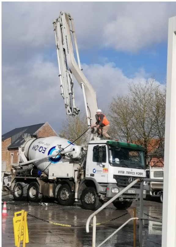
Le chauffeur sur la cabine est en train de déboucher sa canalisation de pompe à l'aide tuyau d'eau
