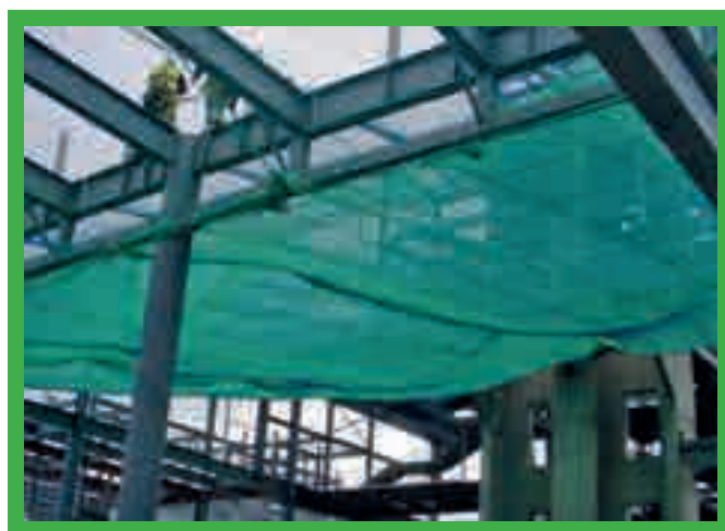
Utilisation de filets de sécurité.
