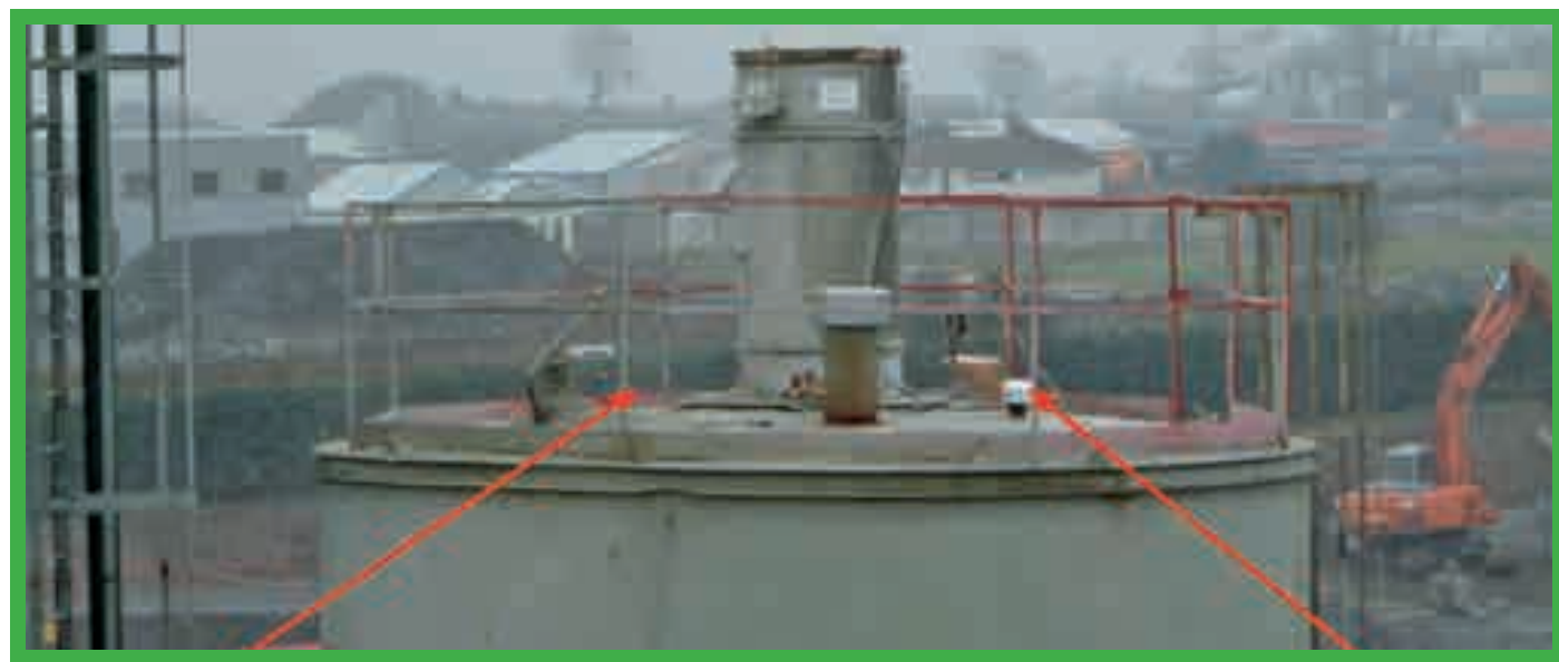
Filtre de silo.
