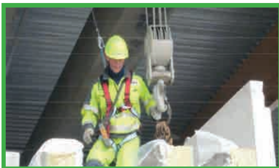
Système d'accès sûr pour l'arrimage et le décrochage des élingues de levage
