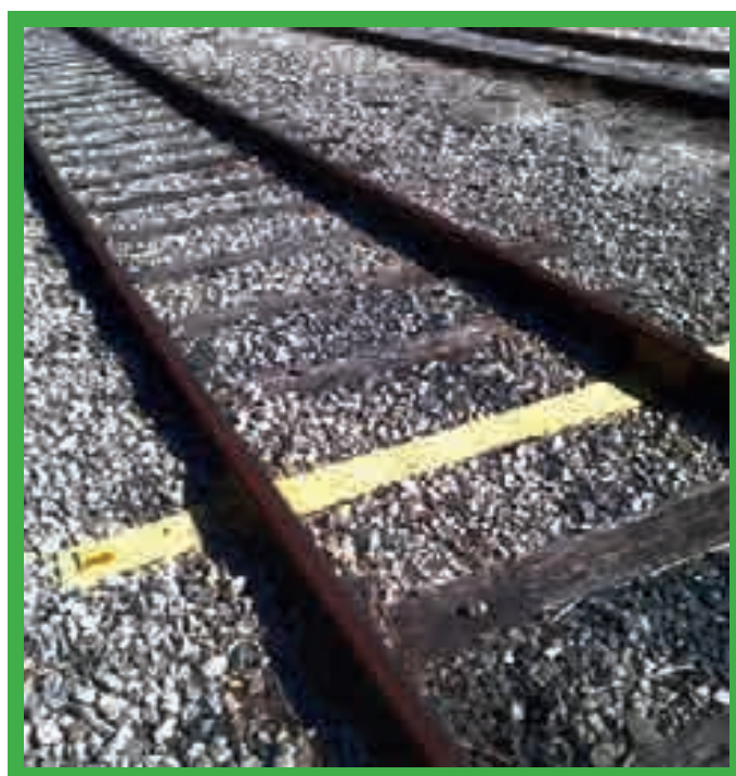
Repères identifiant clairement la position de maintien requise pour les wagons garés
