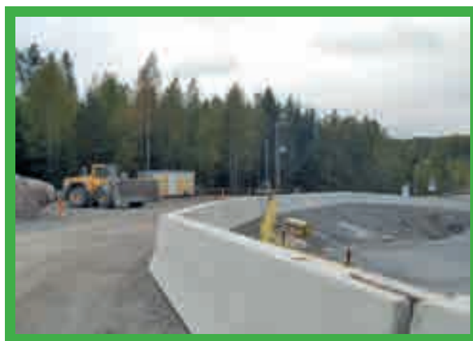
Protection des bords à l'aide de structures préfabriquées.
