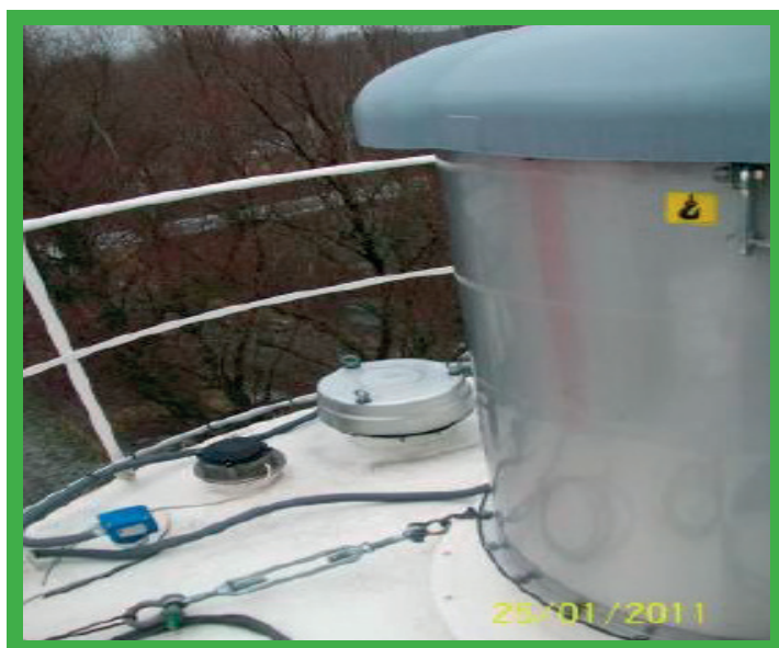
Incident - quasi-accident en 2012 : filtre éjecté dans une zone voisine
