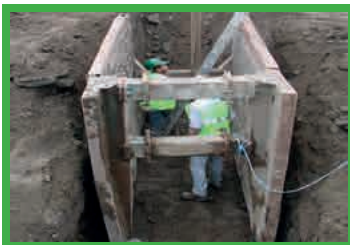
Caissons de tranchée utilisés.
