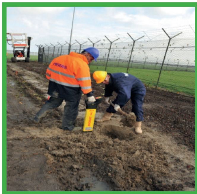
Vérification de la présence de réseaux souterrains avant l'érection de clôtures.
