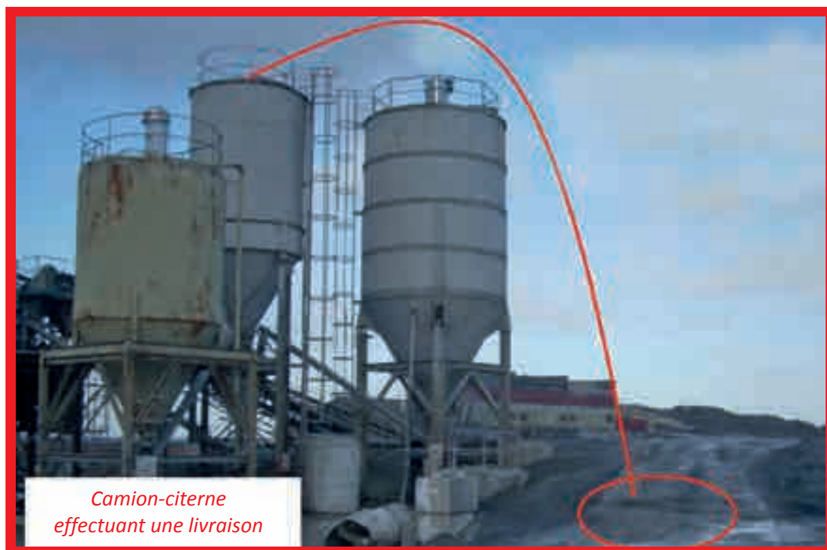
Incident - quasi-accident en 2012 : filtre éjecté dans une zone voisine
