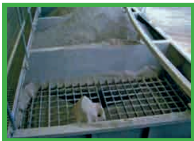
Grilles de protection en place.
