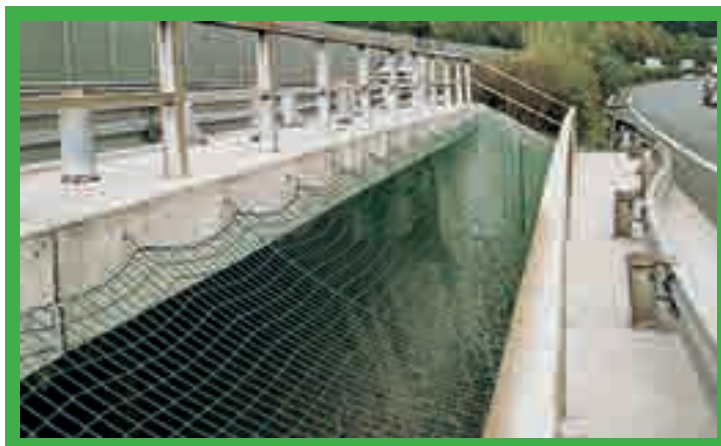
Filet de sécurité en place.
