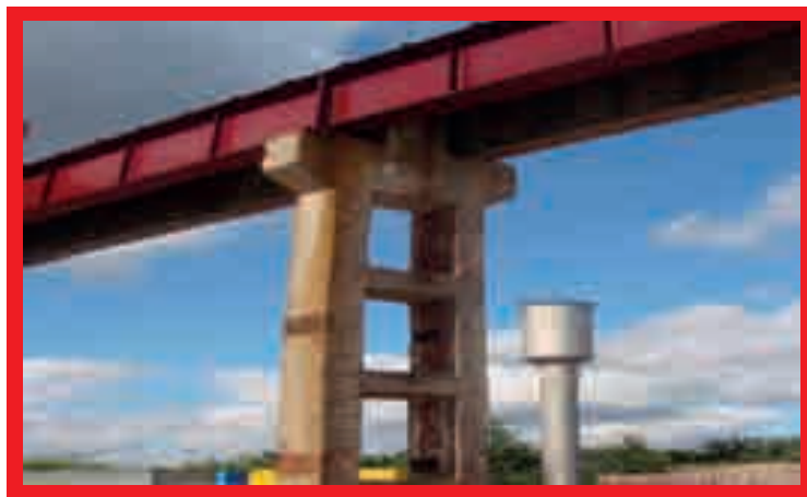
Accident mortel au sein du groupe – étude de cas 2008 : chute d'un contractant depuis le niveau supérieur lorsqu'il descendait. L'évaluation des risques avait identifié la nécessité d'une PEMP (Plateforme élévatrice mobile de personnel), mais aucune plateforme de ce type n'avait été installée.
