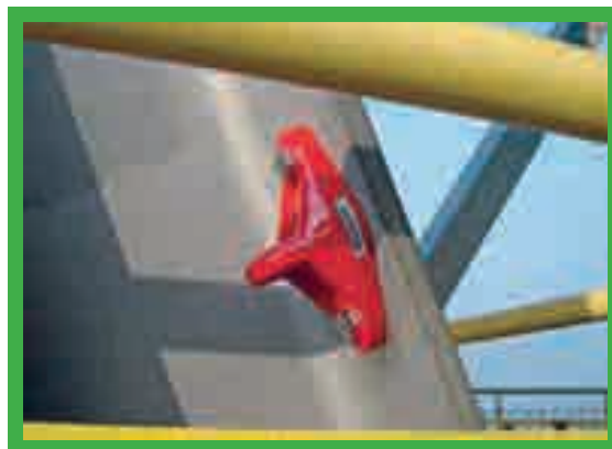
Crochet d'arrimage supplémentaire pour l'utilisation d'un harnais – installé aux endroits requis.
